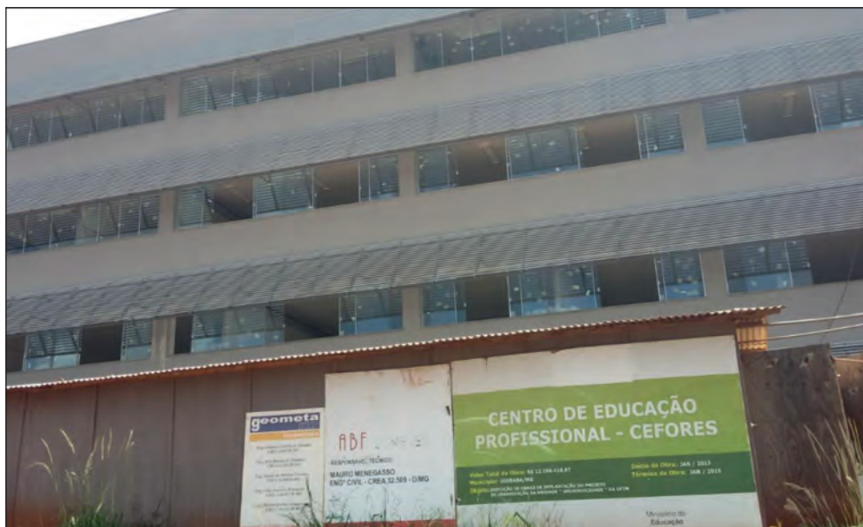
Figura 3 – Prédio em construção na Univerdecidade
