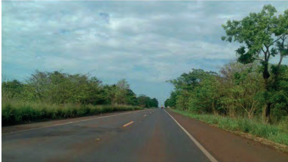
Figura 7.25: Linha do horizonte (rodovia).
